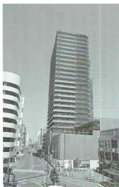
川越は都心からも近く交通も至便。小江戸の雰囲気とは裏腹に、近代的な活況溢れて、最近では高層ビルも目立つようになった
