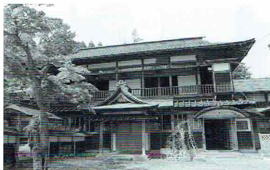
佐藤家(内小友)住宅主屋玄関を望む
